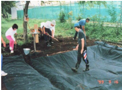
藤沢南小のビオトープ工事
